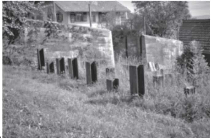
1-4: Von Cudrefin bis Vallamand weist das Geländepanzerhindernis eine Vielfalt von Formen auf: Graben, eingerammte und gegenseitig verstreute Schienen, aus einer Blockreihe bestehende Mauer, Tankmauer und DIN-Profile 5: Werk "Vers le Gibet Nord", welches das nördliche Ende des Hindernisses deckt 6: Übersichtsplan des Dispositivs am südlichen Ende, am Ufer des Murtensees
