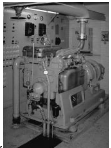
1: Eingänge zum KP 2: Motorenraum 3·4: Wandmalereien von Willy Koch
