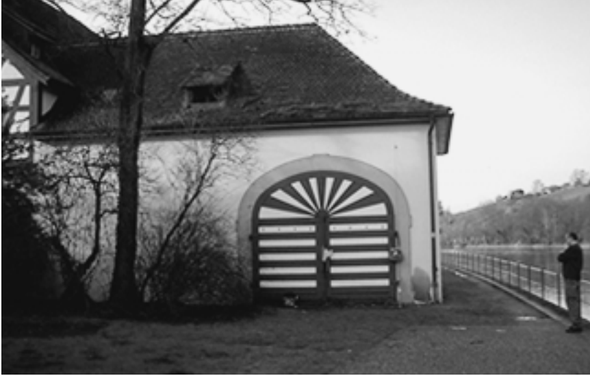
Oben: Ein Bunker am Rhein, getarnt als Remise des Klosters St. Katharinental Mitte und unten: Aussen- und Innenansicht des Klostertores mit Zugschienenbarrikade
