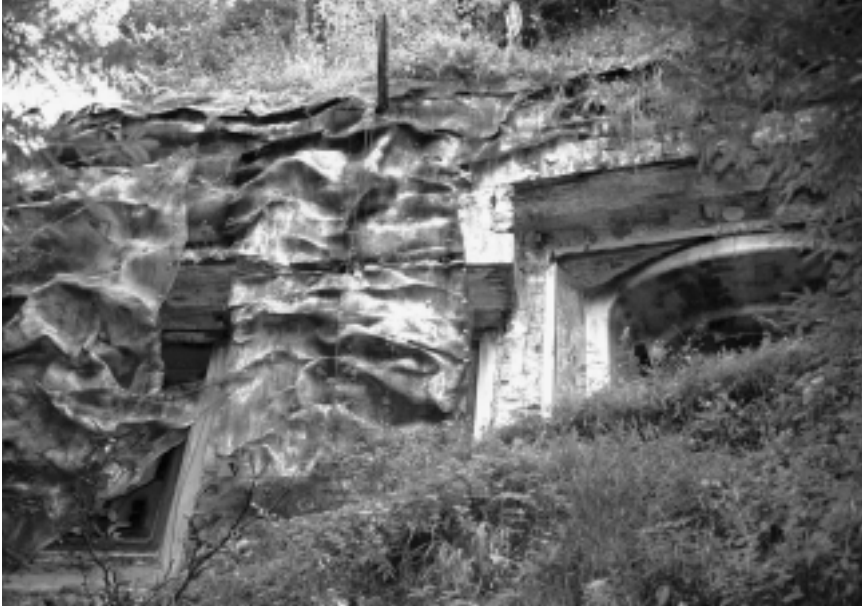
Aussen- und Innenansicht des Infanteriewerks Warmendossen (oben und rechts): Gittertarnung und daneben Schartentopf der 7,5 cm Kanone (einmalig auf der Reduitlinie zwischen Pilatus und Hohgant), Werkeingang, Korridor im Unterkunfts-bereich und Zulaufstollen.
