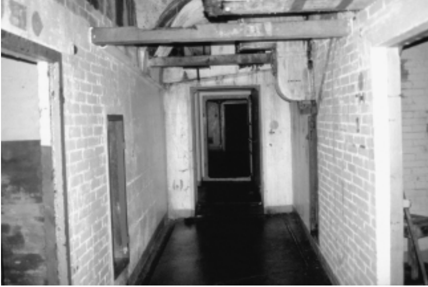
Unterkunftstrakt der Anlage Untere Nase (oben).
