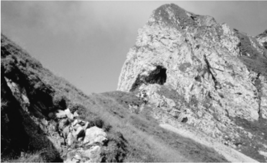
Infanteriewerk Schibengütsch: Eingangsbereich des Werks (links, Bildmitte) und eines Nahverteidigungsstandes (links, linke Bildseite). Ausblick aus diesem «Oststollen» in Richtung Bumbachtal (unten).
