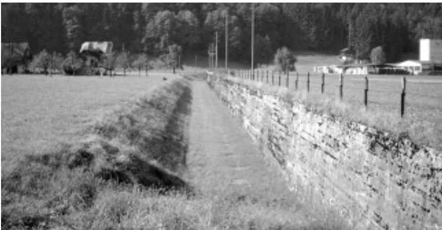
Detail der Tankmauer Oberdorf mit Kontereskarpe und integriertem Leichtmaschinengewehr-Stand (ca. 1943) (ganz oben). Zustand auf der linken Seite der Engelberger Aa vor dem Abbruch (oben), Ansicht des noch existierenden rechten Teils (rechts).
