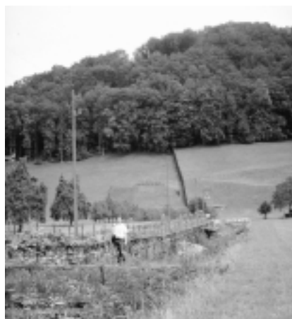
Détails du mur antichars d'Oberdorf (env. 1943) avec la contrescarpe et le poste à fusil-mitrailleur intégré (tout en haut). Etat sur la rive gauche de la rivière Engelberger Aa avant la démolition (en haut), vue de la partie droite encore existante (à droite).
