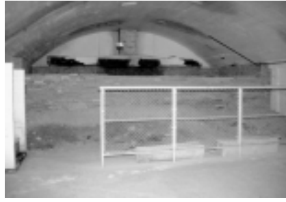
Die unterirdische Bäckerei Rubihütte: Aussen- und Innenansicht (links), Grund- riss und Längsschnitte (unten).
