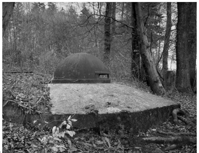
1-2: Fortin est et ouest de l'ouvrage de Flueholz. Un complexe souterrain de plus de 400 m relie ces ouvrages d'infanterie à des observatoires d'artillerie et à un poste de commandement de bataillon 3: Abri bétonné pour un canon d'infanterie et son équipage (élément du renforcement de la position de la Limmat de 1944) 4-5: Double abri d'observation Münzlishausen. Les coupoles d'acier présentes sur l'abri sont typiques de la 8 e division
